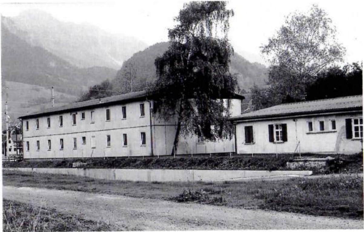
Abb. 9+10: Der Sozialbau (rechts) und das Wohnheim (links); November 1988
