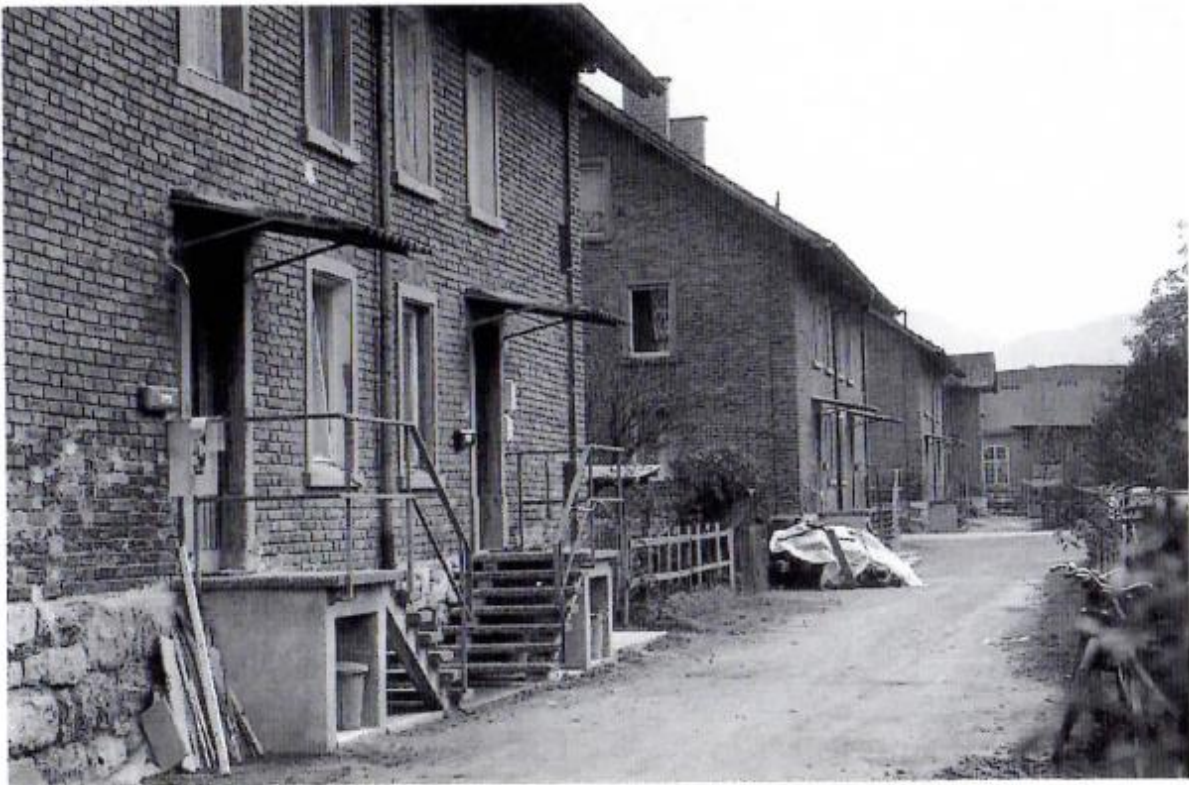
Abb. 4, 5, 6, und 7: Klarenbrunnssiedlung; Objektzustand 1988
